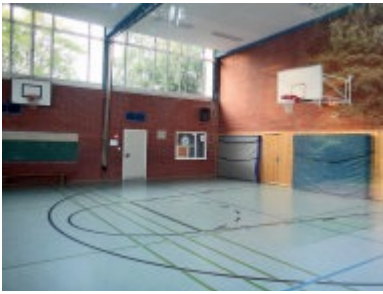
Eine wegen Asbestgefahr gesperrte Hamburger Sporthalle.
