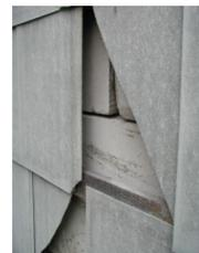
Seit über 120 Jahren kamen einige Mio. Tonnen Asbest in über 3.500 Anwendungsbereichen zum Einsatz. Beispielsweise in der Bauindustrie für Fassaden, Dachabdeckungen, Brandschutz und Wärmeisolierungen. In Dichtungen, Bremsbelägen, Textilien, Gummis und Kunststoffen. Auch in PVC-Böden, Fliesenklebern, Spachtel- und Fugenmassen, in Elektrogeräten und Stromleitungen.
